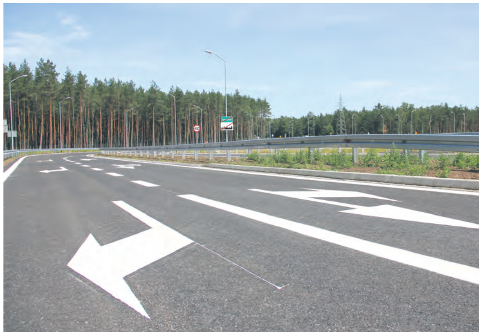
Autostrada A6 jest sukcesywnie modernizowana.
