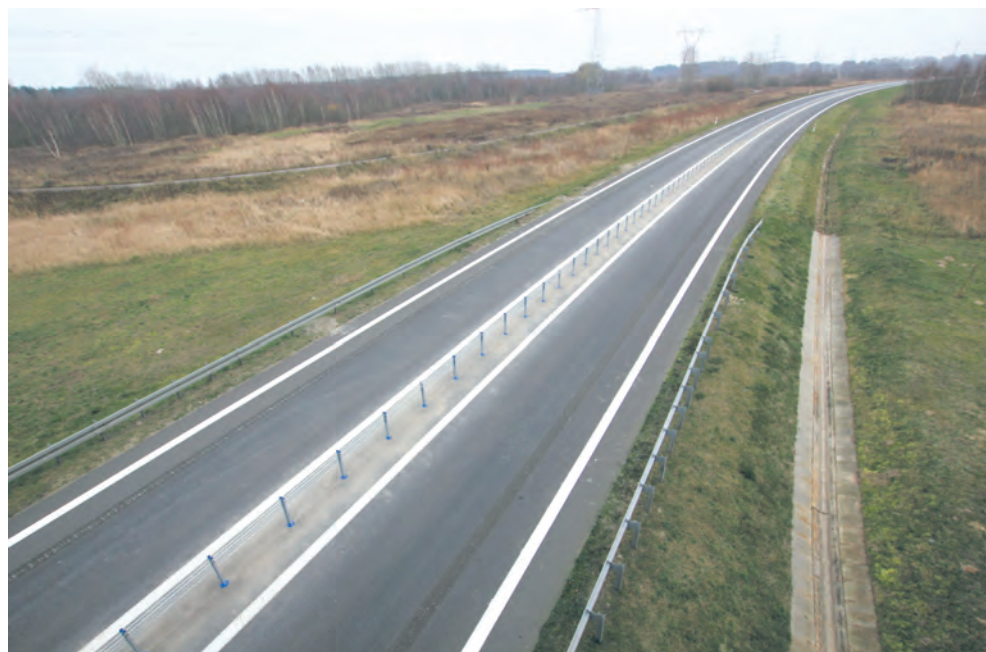
Na obwodnicy Kobylanki bezpieczeństwo zwiększa bariera linowa.
