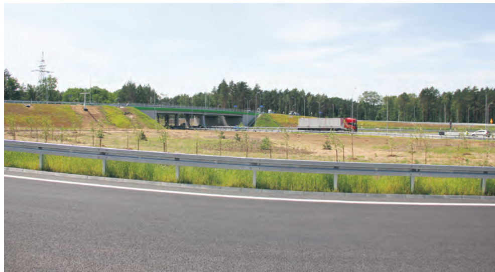
W mijającym roku ukończono budowę węzła „Tczewska”.
