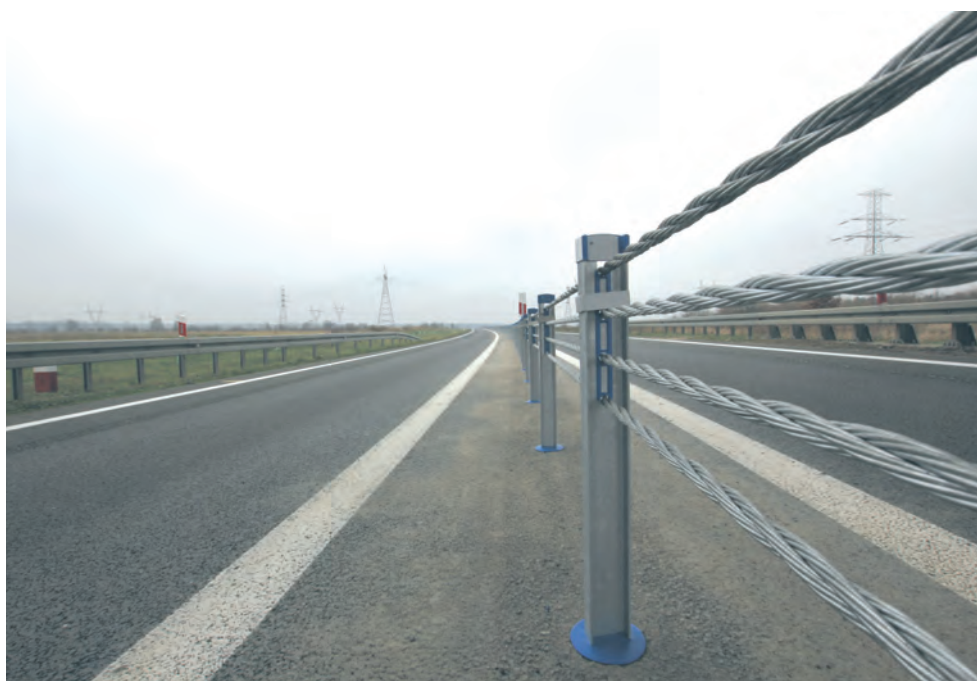
Na obwodnicy Kobylanki bezpieczeństwo zwiększa bariera linowa.
